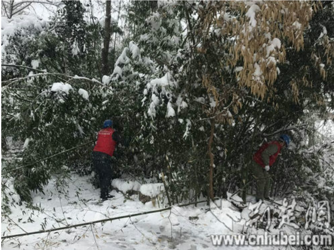
抢修人员施工情景。蔡明坤供图
